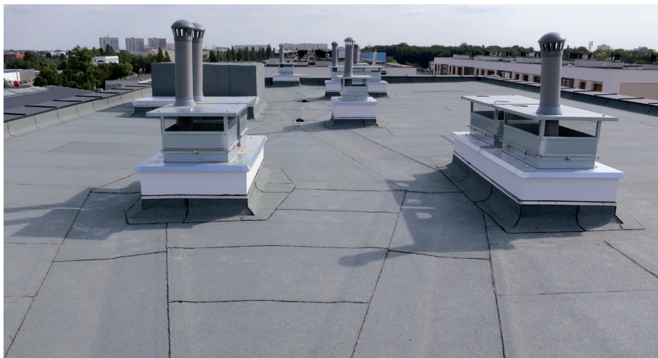
▲ Rys. 5. Spadki stropodachu pełnego prawidłowo kształtuje się w warstwie termoizolacji
