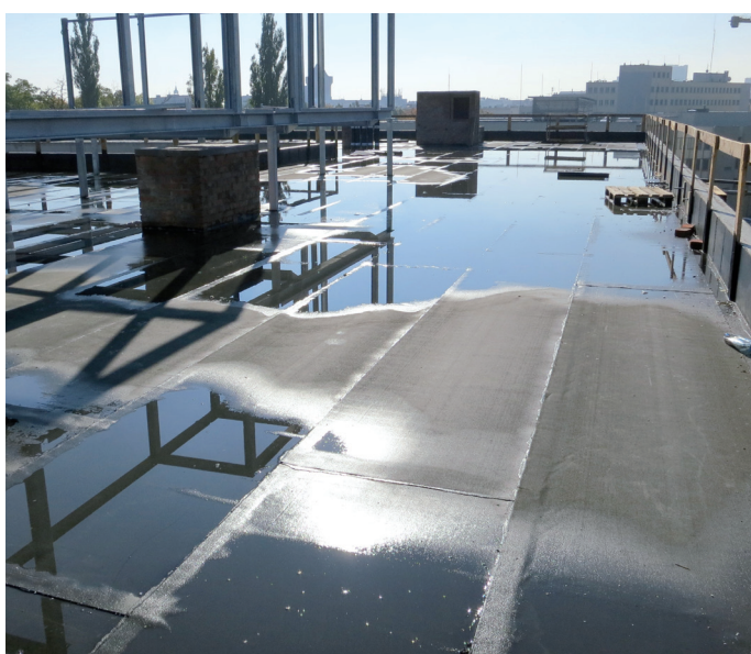
▲ Rys. 6. Na etapie budowy papa paroizolacyjna pełni funkcję papy wstępnego krycia
